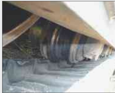
Detracking an einem Laufrad
